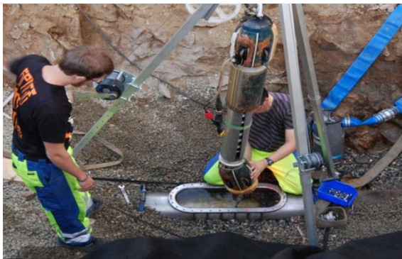
Bild 4. Mätning med Pipescannern kräver uppgrävningsarbete och att en öppning till scannern monteras in i det befintliga nätet [26].
