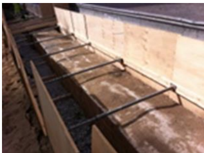
Bild 10. Gamla fjärrvärmeledningar i betongkulvert.
