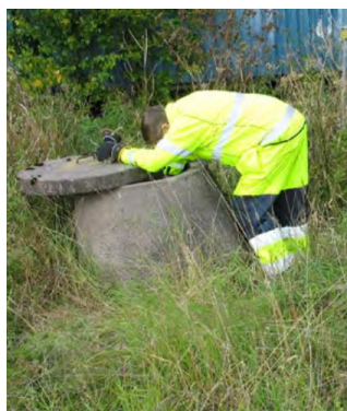
Bild 8. Ammoniummetoden kräver provtagningar från brunnar kring området där det läcker [22].
